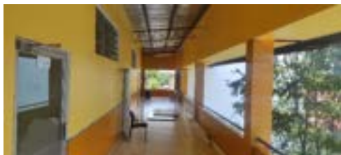
Mantenimiento y reparación pabellón de los 200
